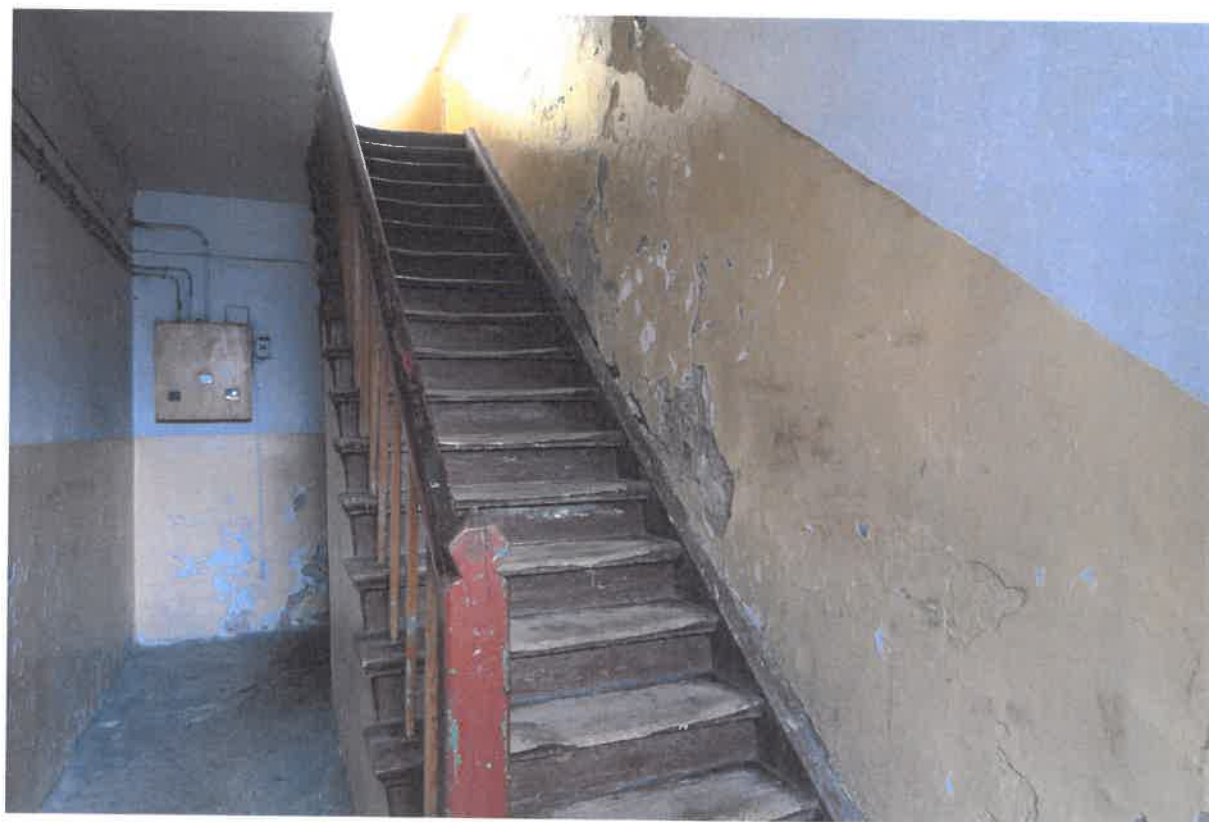
Fotografia 3. Klatka schodowa – budynek mieszkalny.
