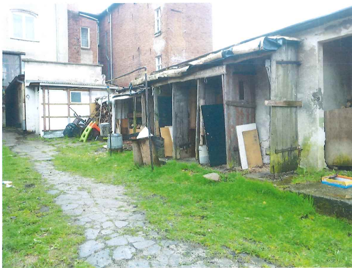
Fot. 11. Podwórko przy ul. Podmurnej.
