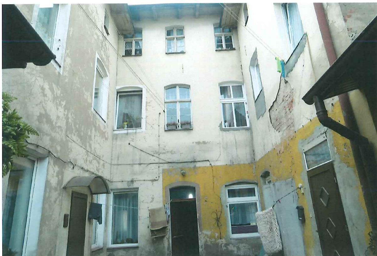
Fot. 4. Elewacja – ul. Mickiewicza.
