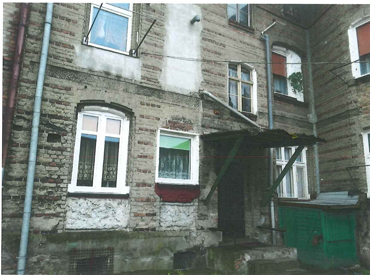
Fot. 5. Elewacja – ul. Mickiewicza
