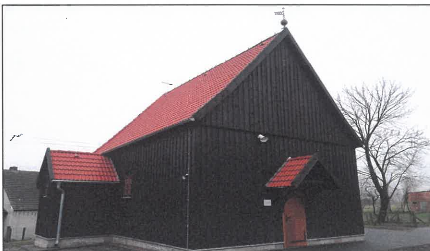
Zdjęcie 28. Po remoncie budynek kościoła pw. Świętego Andrzeja Apostoła w Nadziejewie.
