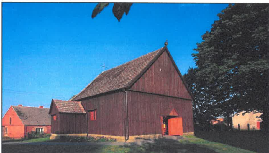
Zdjęcie 25. budynek kościoła Filialnego pw. Świętego Andrzeja Apostoła w Nadziejewie przed remontem
