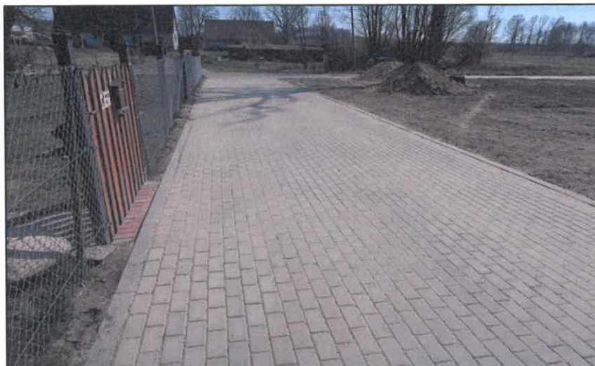
Zdjęcie 29. Modernizacja dróg gminnych wraz z wykonaniem powierzchniowego odwodnienia.
