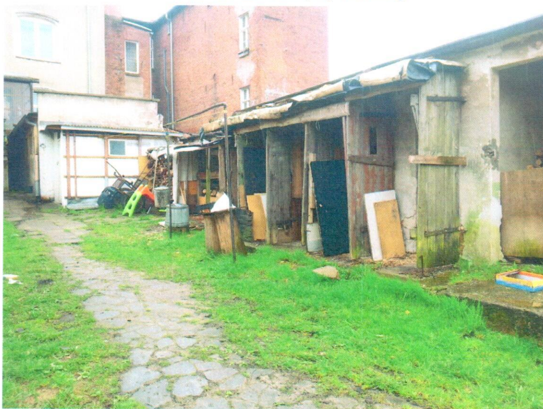
Fot. 11. Podwórko przy ul. Podmurnej.
