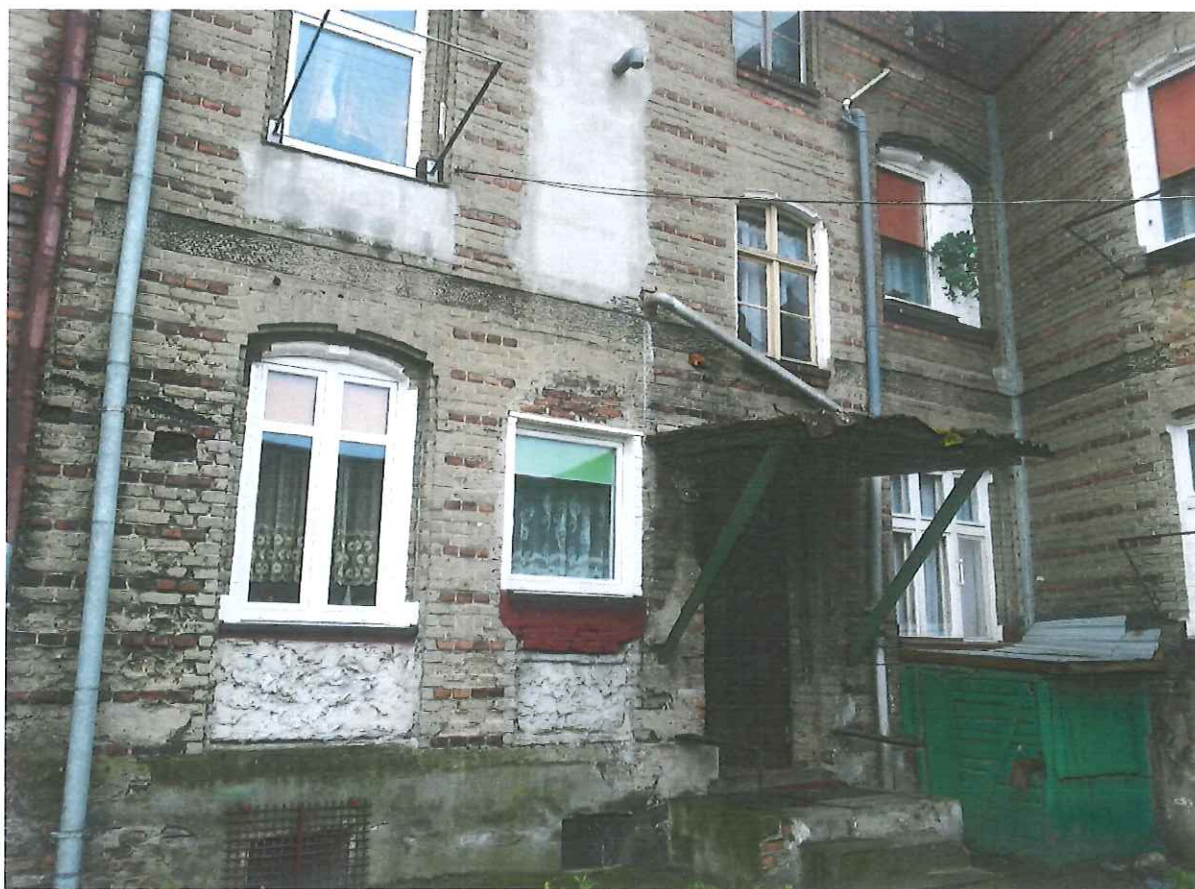
Fot. 5. Elewacja – ul. Mickiewicza
