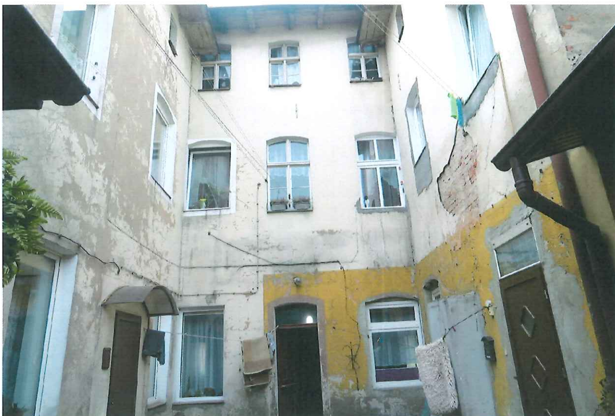
Fot. 4. Elewacja – ul. Mickiewicza.
