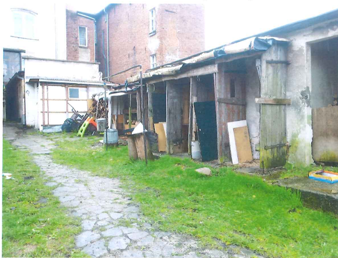
Fot. 11. Podwórko przy ul. Podmurnej.
