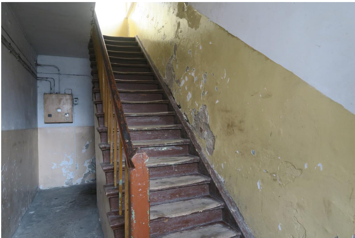
Fot. 3. Klatka schodowa – budynek mieszkalny.
