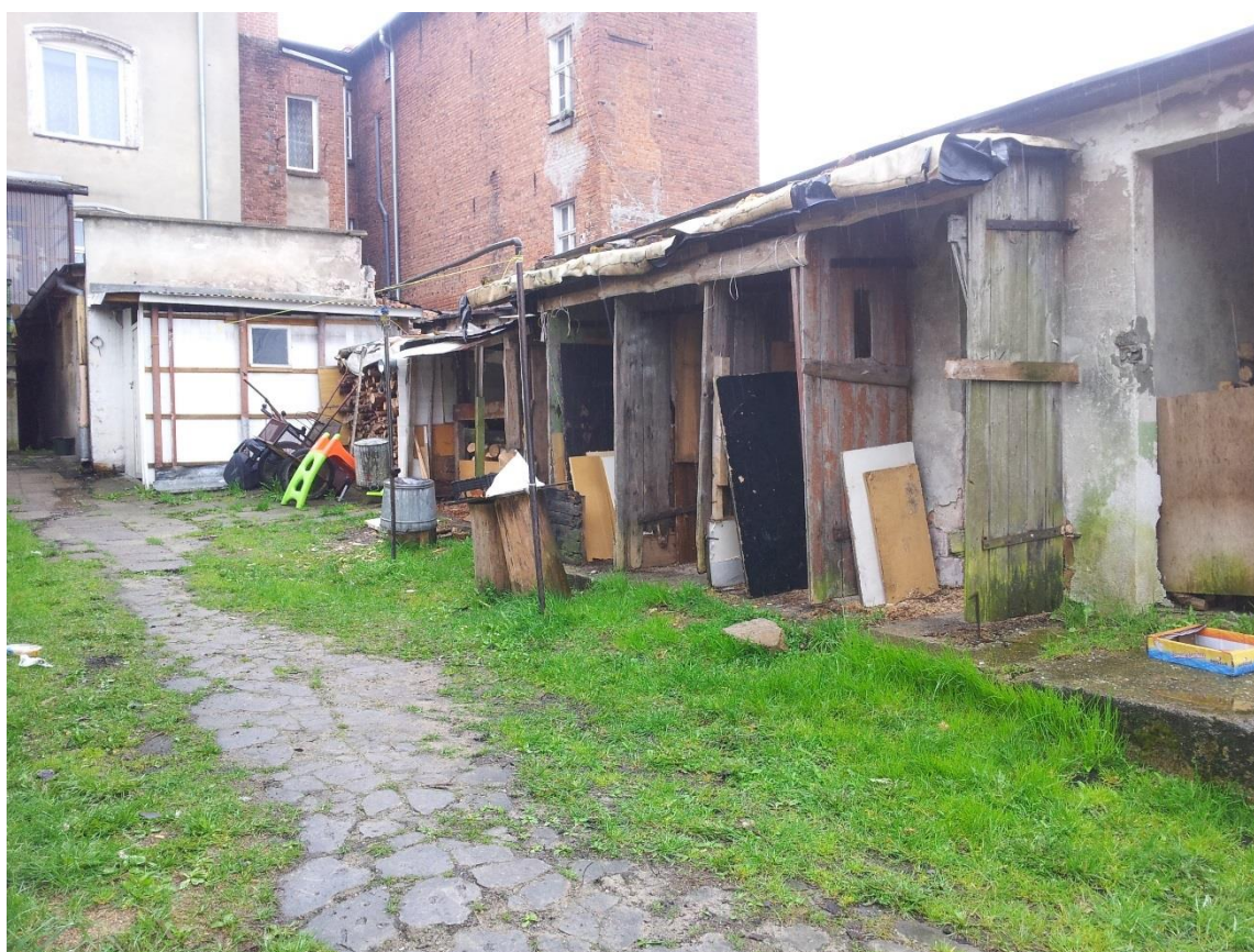
Fot. 11. Podwórko przy ul. Podmurnej.
