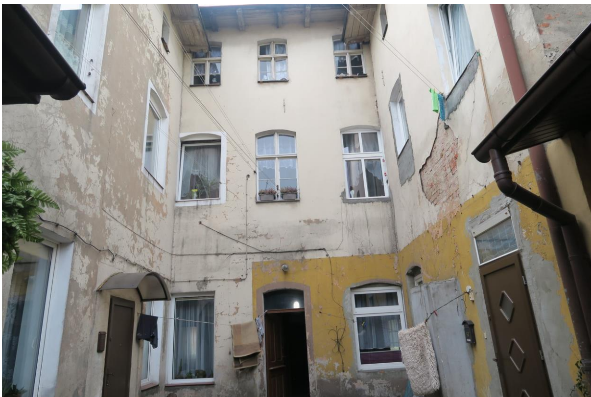
Fot. 4. Elewacja – ul. Mickiewicza.
