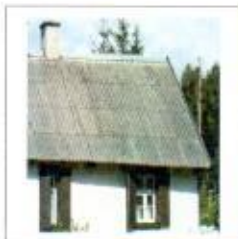
Fot.1 Płyty azbestowo-cementowe faliste
