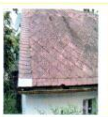
Fot.1 Płyty azbestowo-cementowe faliste
