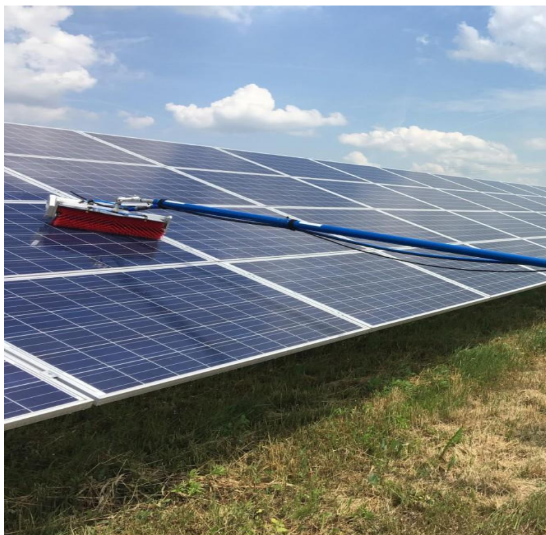
Fot. Mycie paneli fotowoltaicznych
