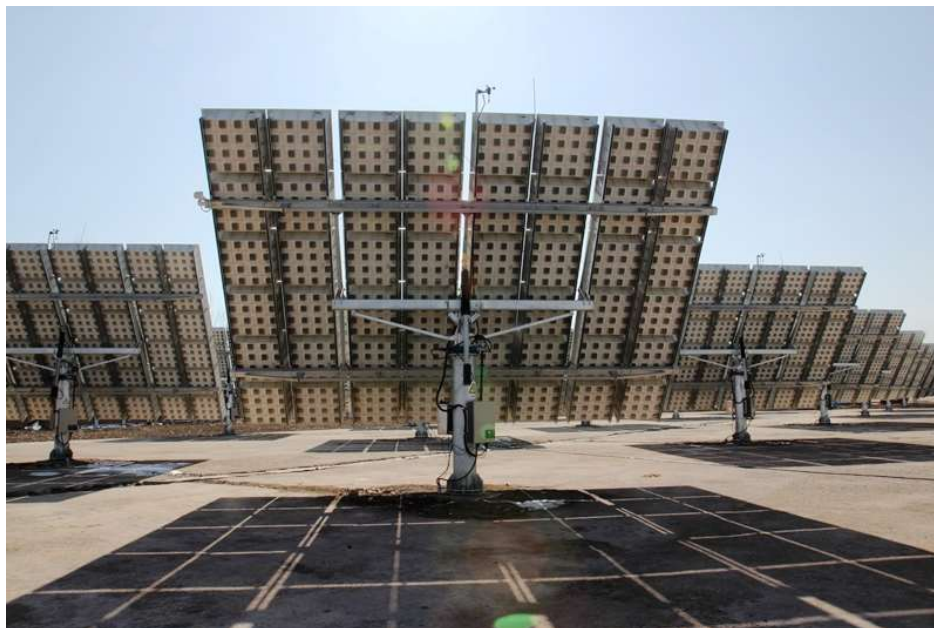
Ryc. 20 Przykład paneli fotowoltaicznych z dwuosiowym systemem trakcyjnym.
