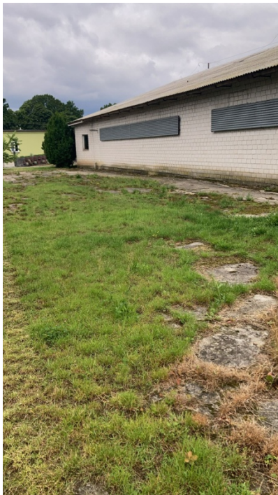
Fotografia 1 Lokalizacja nr 1 - 6 zbiorników
