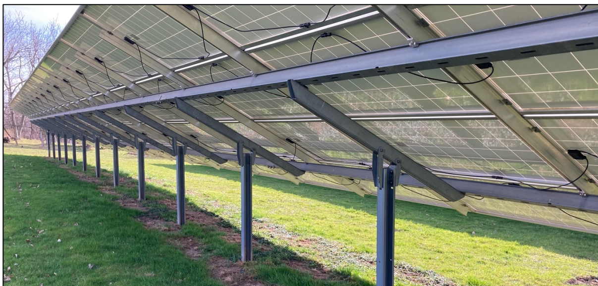
Rycina 14 Przykładowe konstrukcje wsporcze na których montowane są panele (fot. M. Roszyk)
