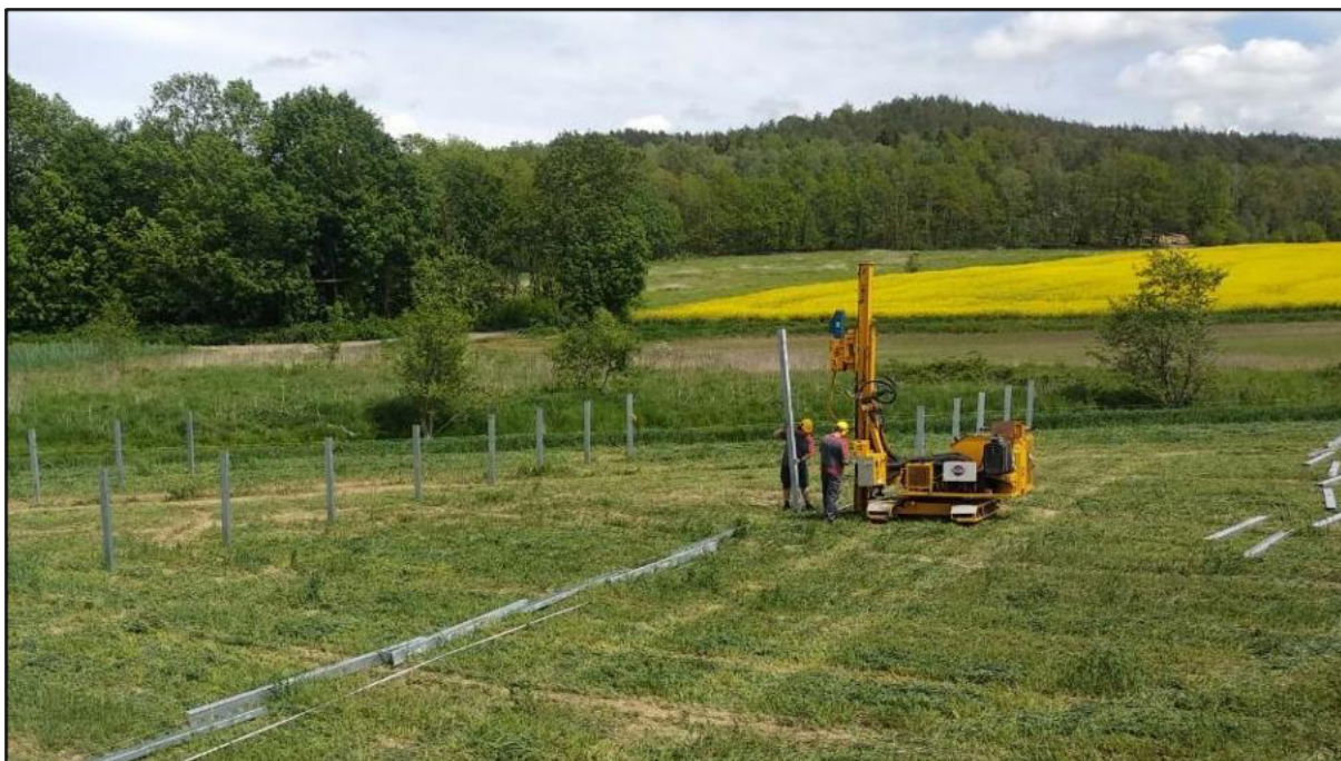
Rycina 12 Mocowanie profili za pomocą kafaru
