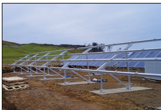
Rycina 46 Sposób montażu paneli na fundamentach betonowych
