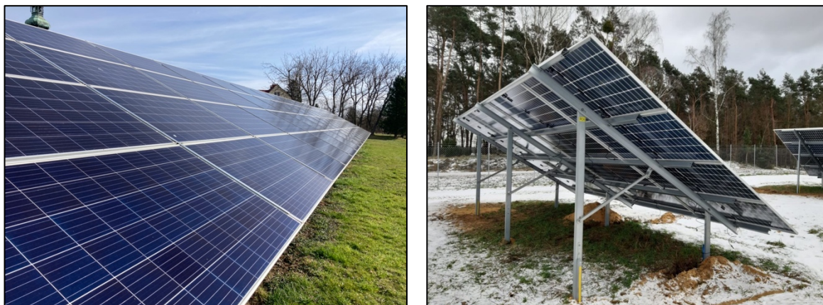
Rycina 13 Przykładowy panel fotowoltaiczny jednostronny (po lewej) i dwustronny - bifacialny (po prawej)
