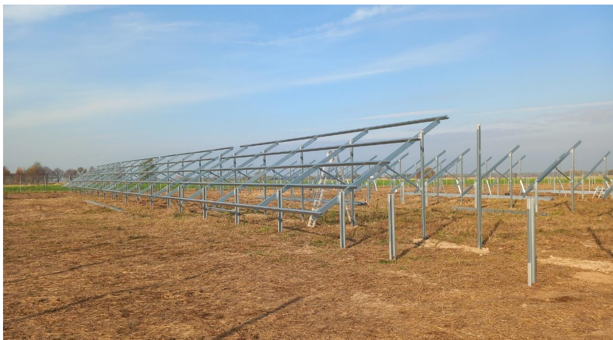
Fot. 3-1: Metalowe stelaże pod moduły fotowoltaiczne
