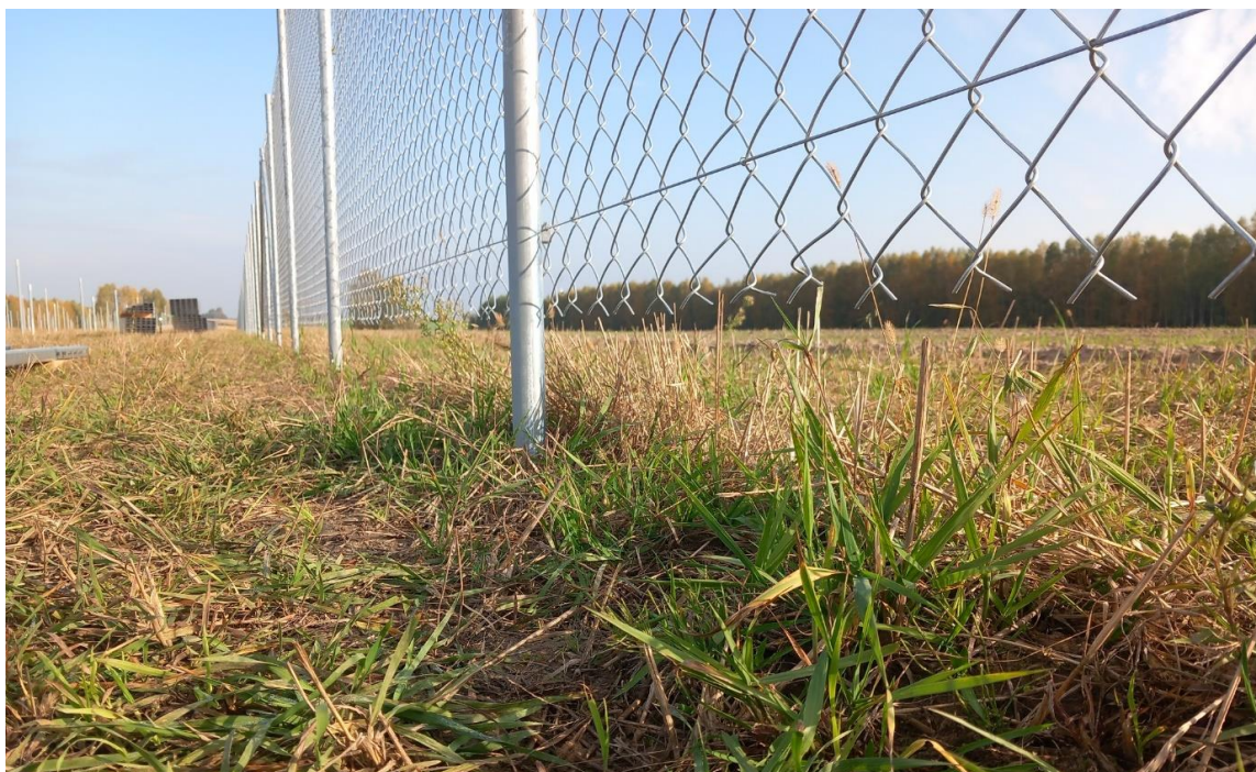
Fot. 7.7-1: Przykładowe ogrodzenie farmy fotowoltaicznej, widoczna przerwa pod ogrodzeniem umożliwiającą migrację drobnej fauny.
