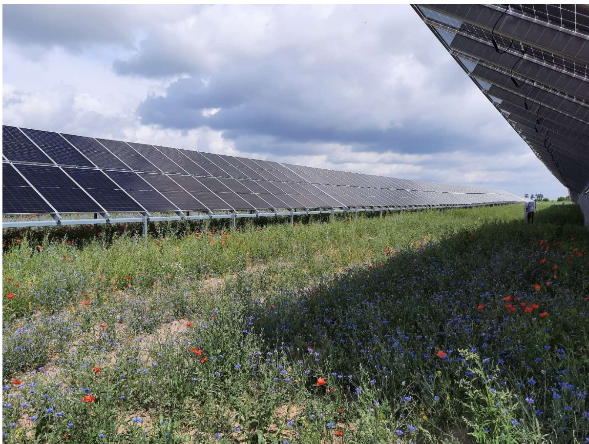
Rycina 1. Powierzchnia biologicznie czynna pod panelami fotowoltaicznymi.
