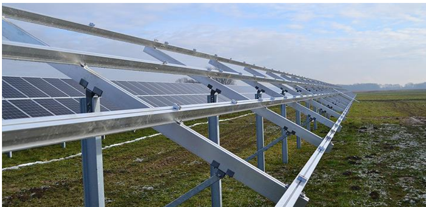
Rys. 8. Przykładowa konstrukcja wsporcza (źródło: https://www.servus-solar.com ).
