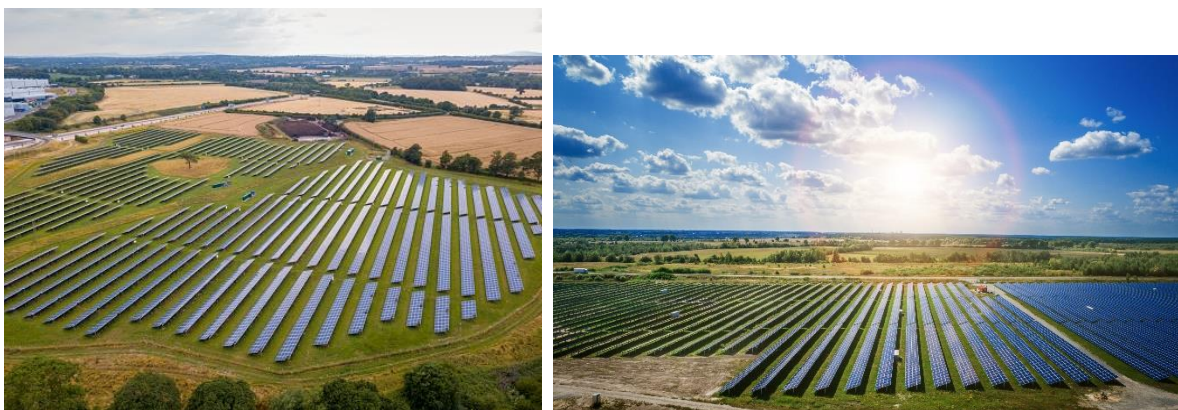
Rys. 3. Przykładowe farmy fotowoltaiczne.
