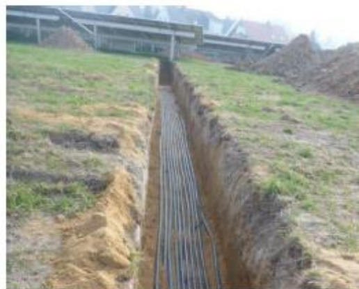
Rys. 15. Przykład wykonania podziemnej linii kablowej.
