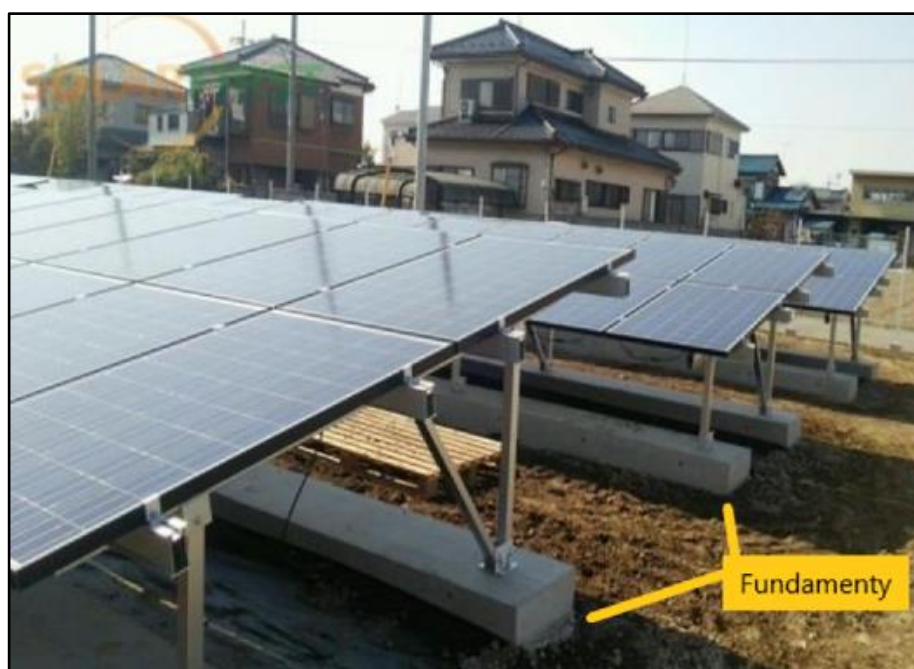
Ryc. 15 Montaż paneli - prefabrykowane fundamenty. Źródło: Google grafika
